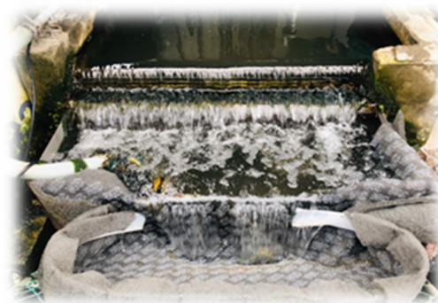
放流口設有過濾棉
